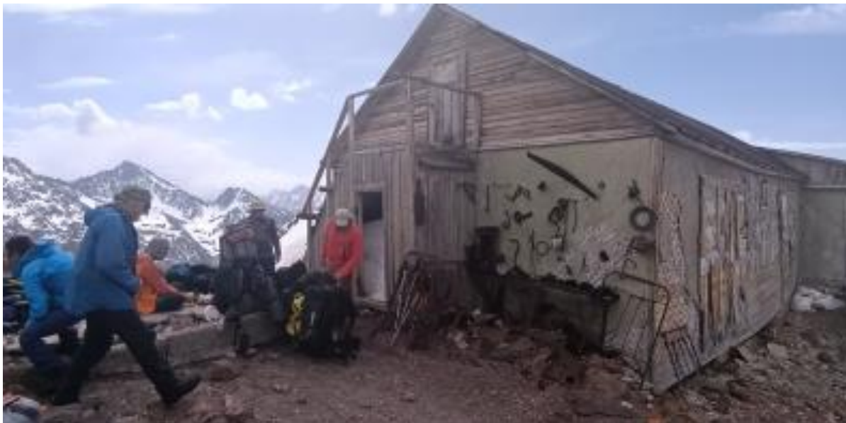
Фото 18. 105 пикет. Состояние внутри.
