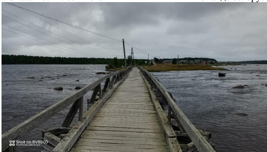
Мост через Калгу
